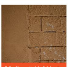
7. Das Mauerwerk wird mit Lehmputzen verputzt. Begonnen wird mit dem Sprühen, danach wird der Grobputz aufgetragen.
