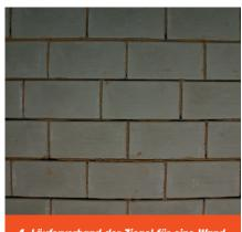
4. Läuferverband der Ziegel für eine Wandstärke von 25 cm.
