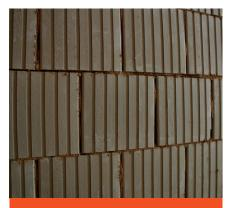
3. Läuferverband der Ziegel für eine Wandstärke von 12 cm. Lager- und Stoßfugen werden immer mit einer Mörtelschicht von 10 mm versehen.
