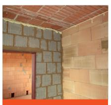
5. Mauerwerke aus ungebrannten Ziegeln können in einem Ziegelhaus als Trennwand verwendet werden.
