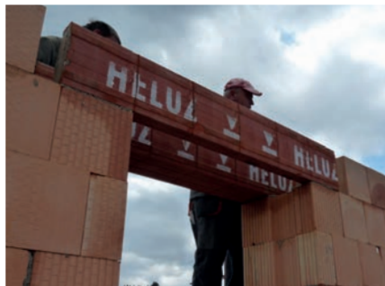
Verarbeiten und Anordnung der Stürze (Stürze HELUZ 23,8) ins Mörtelbett.
