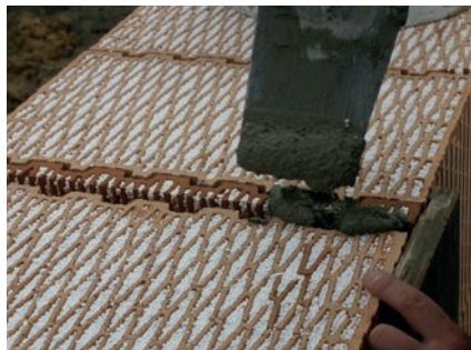
Spalten zwischen Ziegeln sind mit Mörtel oder mit Ziegelzuschnitten zu verfüllen bzw. auszumauern.
