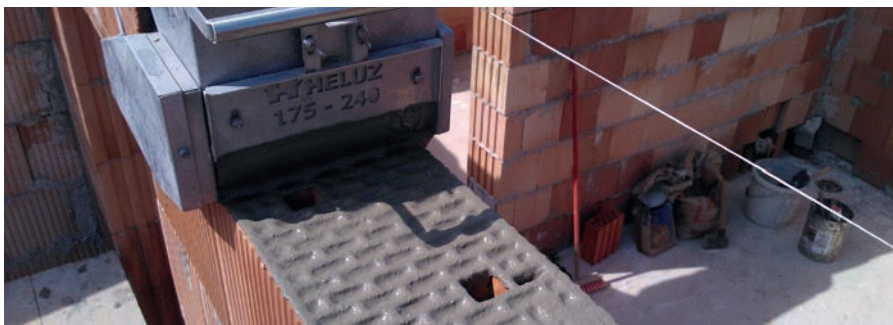
Mauerung der tragenden Innenwände.
