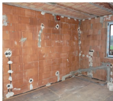
Ansicht auf eingebaute Elektroninstallationsdosen und verlegte Kabel. Schlitzte für Wasser- und Abwasserleitungen müssen möglichst klein sein.
