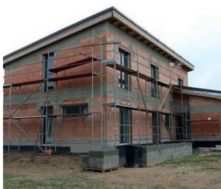
④ Vorbereitung des Baus vor dem Verputzen. Vor dem Verputzen wird eventuell das Mauerwerk ausgebessert und es werden die am meisten exponierten Stellen der Konstruktion behandelt.
