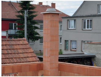
Bau des Kamins und fertiggestellter Kamin.
