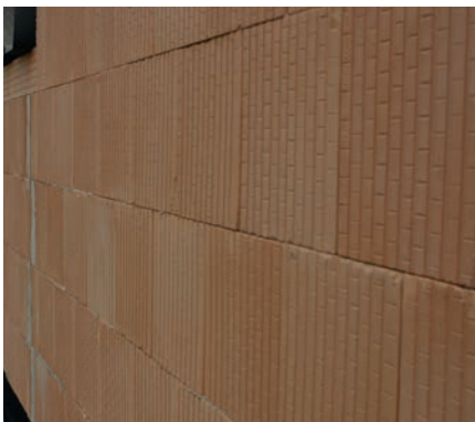
Der Untergrund für Putze muss eben sein.
