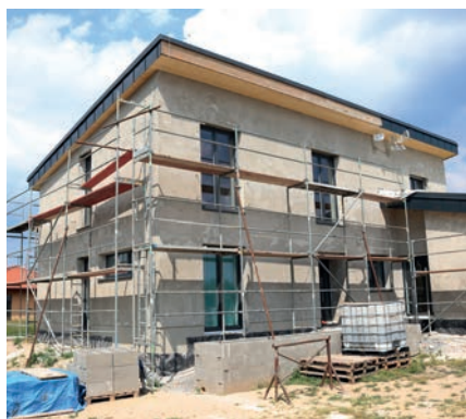
⑤ Durchführung des Unterputzes (Leichtputz oder wärmedämmender Putz).
