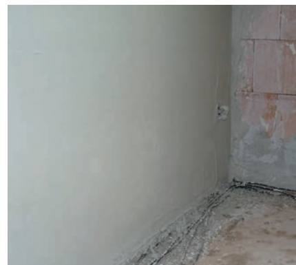
③ Innenputze werden vom Rohbau Fußboden bis zur Decke durchgeführt.
