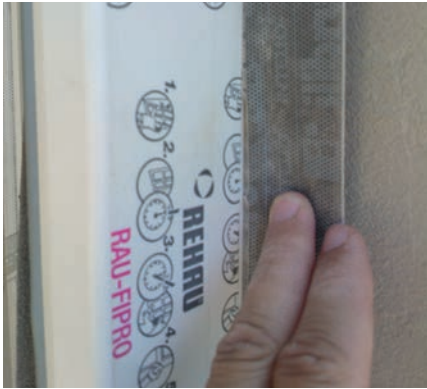
⑨ Aufkleben der verputzbaren Fensterbänder.
