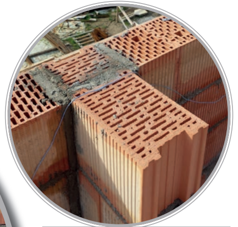
Das AKU Mauerwerk wird in der Regel bis zur Vorderseite des Außenmauerwerks oder des Innenmauerwerks gemauert
