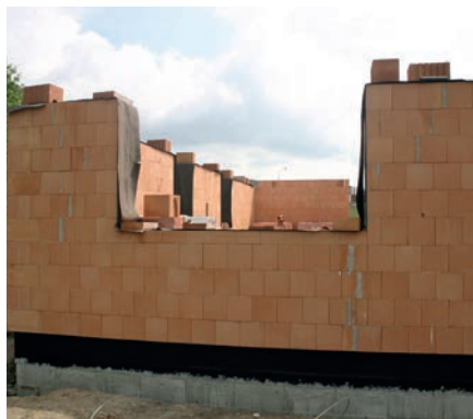
③b Mauerwerk im Bereich der Fensterbänke muss man gegen Regen schützen.
