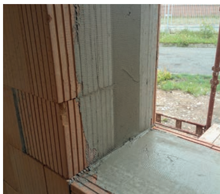
⑥ Vor der Fenstermontage wird das Styropor mit einem Zementkitt verspachtelt, der mit einem Glastextilgitter ausgesteift wird.
