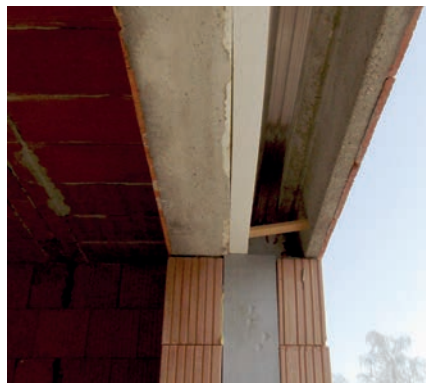
④ Der Laibungssturz mit eingesetztem Rollladen- und Jalousiensturz HELUZ.
