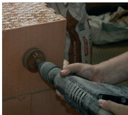
Zum Bohren von Öffnungen der Elektroinstallationsdosen wird die Verwendung eines Kernbohrers empfohlen.
