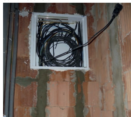
Die Schlitzte für Leitungen sollten vor dem Verputzen ordnungsgemäß mit Mörtel geschlossen werden.
