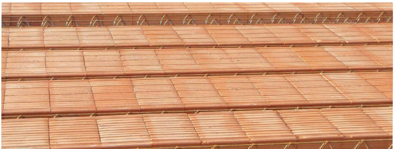
Ansicht auf die verlegten Träger und Einlagesteine (vor der Verlegung der Bewehrungsnetze)
