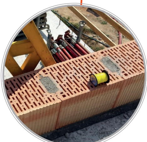
Ausfüllen der Mörteltaschen
