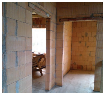
① Laibungen der Bauöffnungen im Innenmauerwerk werden mit der Seite der Ziegel abgeschlossen, welche Nut oder Feder aufweisen.
