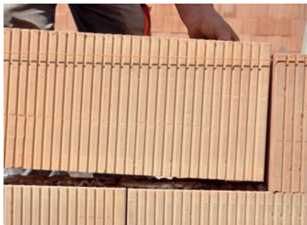
Geschliffene Ziegeln mit der Höhe von 249 mm; die Überlappung beträgt 1/2 der Ziegellänge oder mindestens 100 mm.
