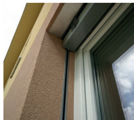
⑨ Ansicht auf die finale Durchführung der Bauöffnung mit einer Jalousie im Rolladen- oder Jalousiensturz HELUZ.
