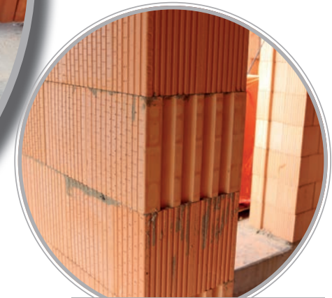
Die Laibungen der Bauöffnungen werden mit Nuten bzw. Federn abgeschlossen
