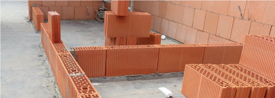
Mauerung von nicht tragenden Wänden (Trennwände).
