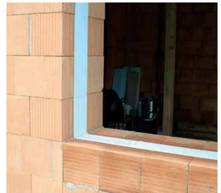
③a In die vorbereitete Tasche wird extrudiertes Styropor eingesetzt.
