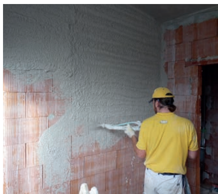
① Maschinelles Auftragen des Innenputzes.
