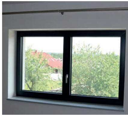
⑬ Fertige Ansicht auf die Durchführung der Bauöffnung von der inneren Seite.
