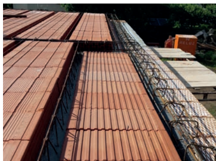
Ausführung der aussteifenden Betonroste.
