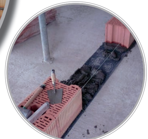
Anlegen auf ein schweres Bitumenband mit einer Mindeststärke von 3 mm als Schutz gegen aufsteigende Feuchtigkeit
