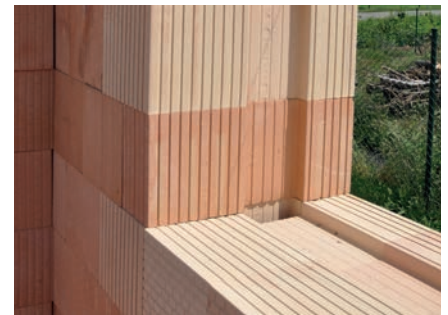
Ergänzende Ziegel (K, K-1/2, R) und ein Beispiel ihrer Verwendung in Laibung und Brüstung.
