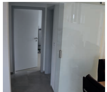
② Ansicht einer fertigen der Bauöffnung - Innentür.
