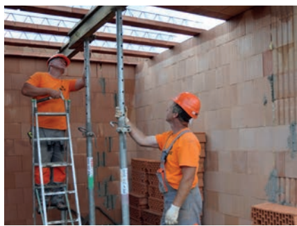
Unterstellung der Decken MIAKO.
