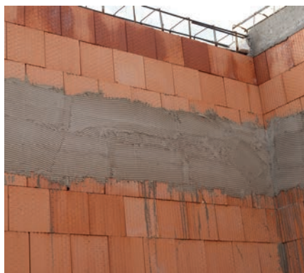
⑧ Wo es keinen homogenen Ziegeluntergrund gibt, wird diese Stelle mit Zementmörtel geschlossen und mit einem Glastextilgitter mit einer Überdeckung von mind. 100 mm armiert.
