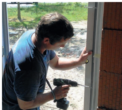
⑦ Fenstermontage - zuerst wird der Fensterrahmen eingesetzt und ausgerichtet.
