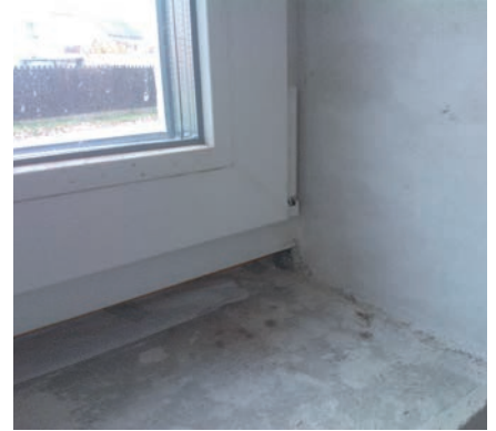
⑪ Ansicht auf den Fensterbankanschluss an die Laibung nach dem Verputzen und vor dem Einsetzen der finalen Innenfensterbank.
