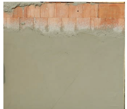
Das Verputzen wird üblicher Weise in drei Schichten, auf manuelle oder maschinelle Weise durchgeführt.
