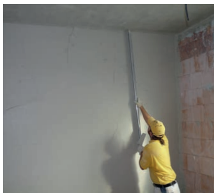
② Ausgleichen des Putzes.
