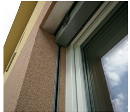
⑭ Ansicht auf die fertige Durchführung der Bauöffnung mit einer Jalousie im Rollladen- oder Jalousiensturz HELUZ.
