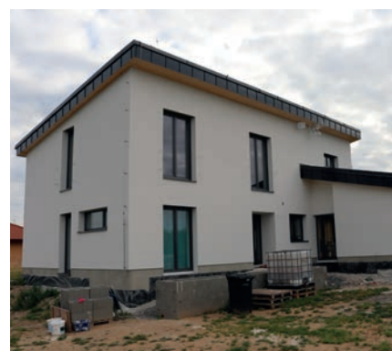
⑥ Fertiggestellte Außenputze.
