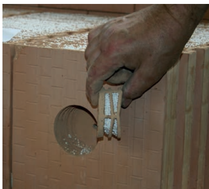
Zum Bohren von Öffnungen der Elektroinstallationsdosen wird die Verwendung eines Kernbohrers empfohlen.
