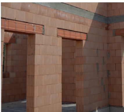
① Laibungen der Bauöffnungen im Innenmauerwerk werden mit der Seite der Ziegel abgeschlossen, welche Nut oder Feder aufweisen.
