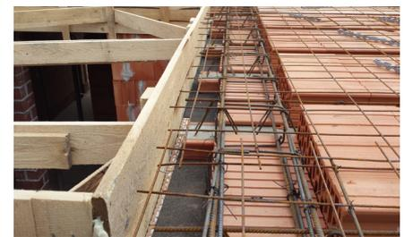
Die Netze müssen am Umfang hinter die innere Stirnseite des Mauerwerks eingezogen werden; Deckschicht der Bewehrung im Kranz von min. 20 mm.
