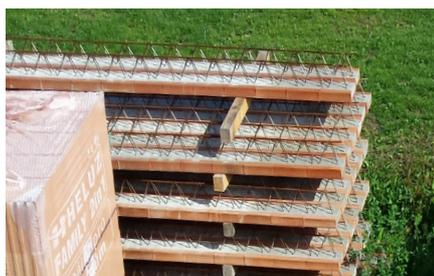
Überprüfen Sie anhand der Zeichnung der Deckenstruktur das gelieferte Material – Typ, Abmessungen und Anzahl der Deckenträger, Einlagen und Ringankersteine.
