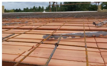
Die Netze werden auf die Deckeneinlagen und Unterlagen (Abstandshalter) gelegt, um eine Mindestüberdeckung von 15 mm zu gewährleisten.
