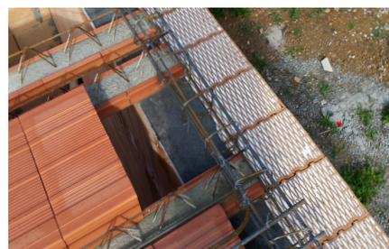
Der Asphaltstreifen mit einer Dicke von min. 3,5 mm wird nur an der Verlegungsstelle der Decke und des zukünftigen Stahlbetonkranzes verlegt!
