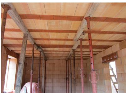
**Abstand der Reihenstützen zueinander oder zwischen der Stütze und dem Mauerwerk ist max. 1800 mm.**
