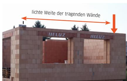
Es wird empfohlen, lichte Weite der tragenden Wände (Ziehsteine) vor der Montage zu überprüfen – Toleranz max. +20 mm.
