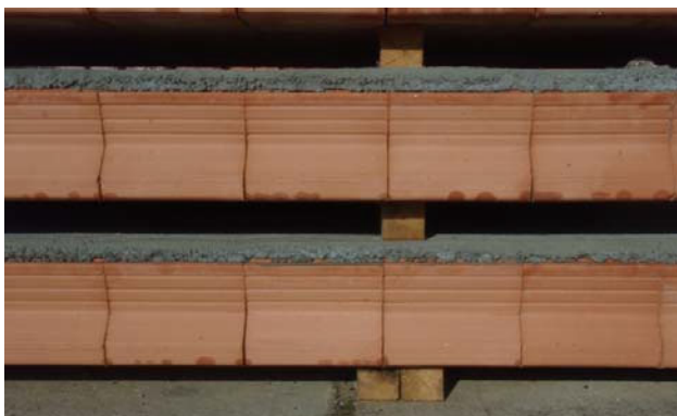
Obr. 10 První panel ve skládce se podkládá dvěma proklady
