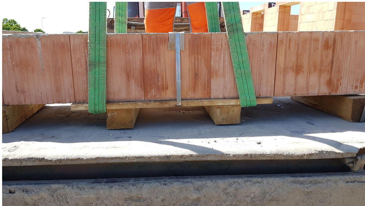
Obr. 6 Ukázka správné manipulace překladu – provlečení popruhů manipulační paletou.
